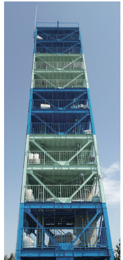
10階規模 排水試験タワー (埼玉県 秩父工場内)
