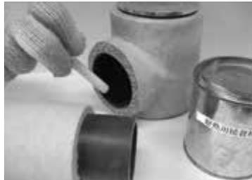
直管接着しろの位置にマジックペン等で標線を記入します。管継手の受口全面と管端から標線までを耐熱用接着剤で均一に刷毛等で塗布してください。
