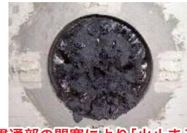
貫通部の閉塞により「火止まる」
