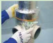
スラブ埋め戻し時の遮音シート保護の為、床防水処理(※1)が終了するまで、上部遮音パーツをスリット部に沿って折り返し、本体付属の輪ゴムにて仮留めします。(スリット=切り込み)
