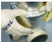
パイプと継手類の接合部にはALGCテープ等による仕上げを行います。(上流・下流共に)
