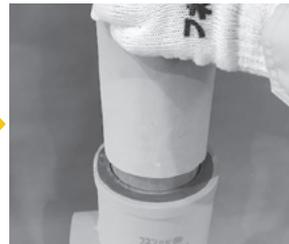
ゴムリングストッパー部分まで直管内管 (塩ビ管) を挿入しマーキングで位置の確認をします。
