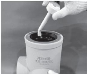
ゴムリング内部の2個のリップ部に滑剤を塗布します。
