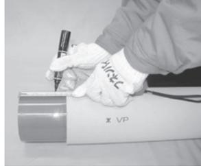
内管塩ビ管端部を面取りし、挿入部分を清掃して挿入しるをマーキングします。
