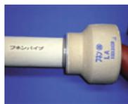
④ 耐火と固定の処置として耐火被覆パーツの両端部の隙間を塞ぐように、付属の不燃性テープで上流側→フランジ側の順に貼り合せて終了です。
