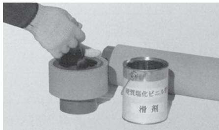
塩ビ管用滑剤を内管の挿入部及びゴムリングに刷毛等で塗布します。
