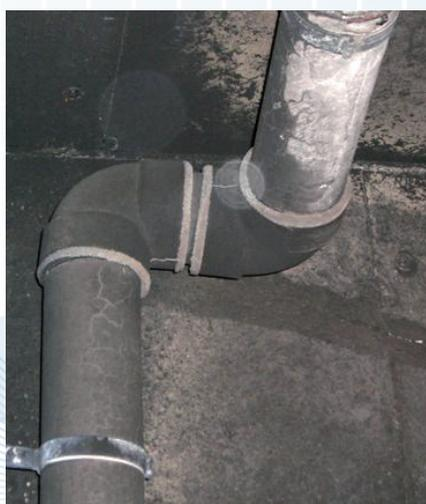
実際の火災後の現場写真。配管が保持され、継手に組込まれている熱膨張目地材が膨張し、接合部の隙間を塞ぎ有害ガスの漏洩を防いでいます。
