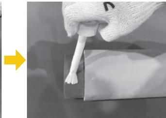
挿入しるの確保と面取りを行なった塩ビ管に滑剤を塗布します。
