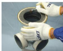
アクロスジョイント(上部)のゴムリング内側2個のリップ部分と直管塩ビ管外側に滑剤を塗布します。
