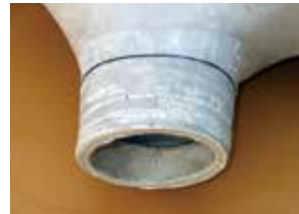
⑥ 継手部分への防水シール剤の塗布
